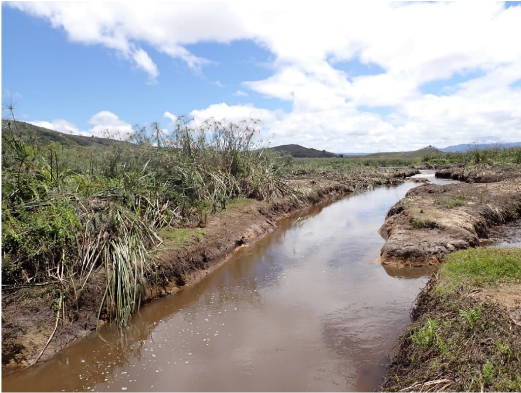
Photo montrant l'ancien canal principal traversant le sol argileux protégeant la zone de marais en aval du lac qui vient de s'élargir après l'évènement du 11 Février 2024
